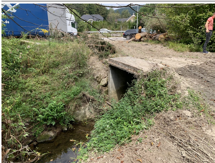
Slika 6: Pogled na prvi prepust na obravnavanem odseku na Trebušnici (skrajno dolvodni prepust).
