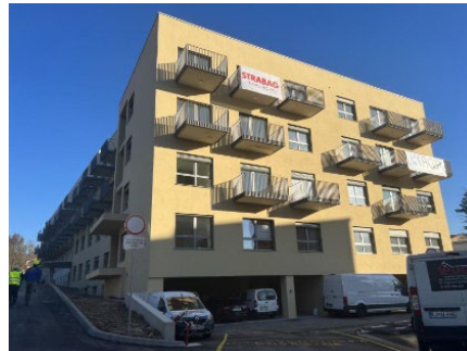
Slika: Pogled na nov dom iz Bračičeve ceste
