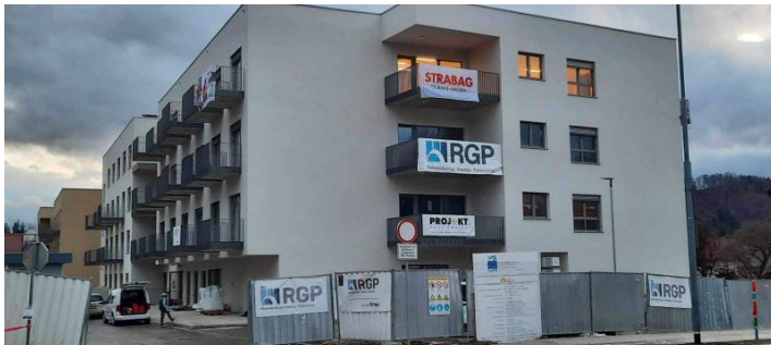
Slika: Pogled na nov dom iz Kidričeve ceste
